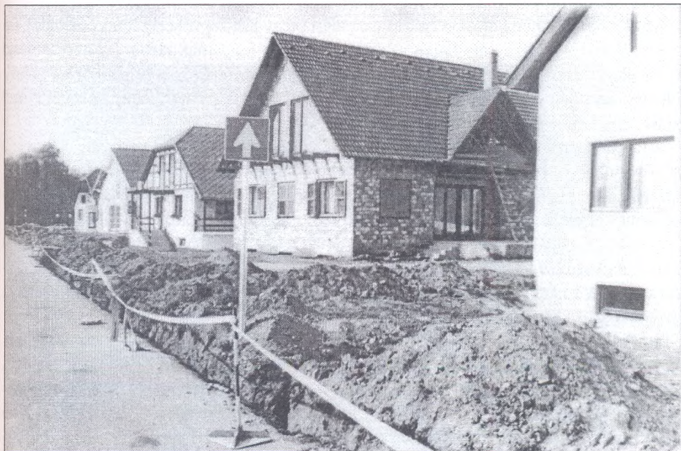
84. A gáz, a telefonvonalak kiépítése, csatornázás az Újtelep elején, az 1990-es évek elején
